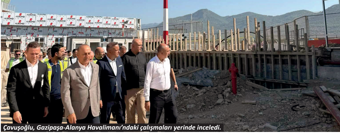
Çavuşoğlu, Gazipaşa-Alanya Havalimanı'ndaki çalışmaları yerinde inceledi.
