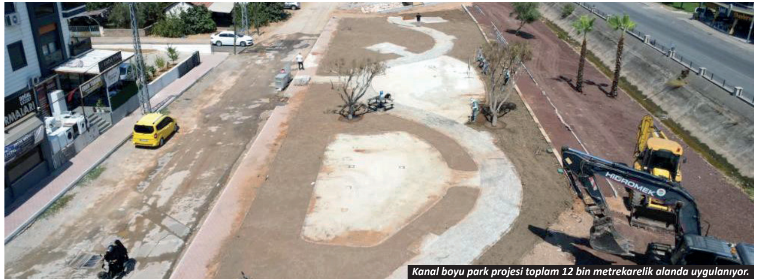
Kanal boyu park projesi toplam 12 bin metrekarelik alanda uygulanıyor.
