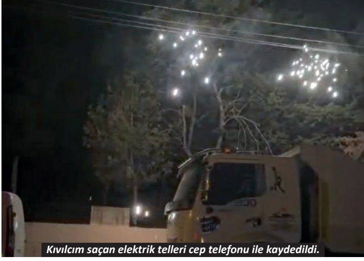
Kıvılcım saçan elektrik telleri cep telefonu ile kaydedildi.
