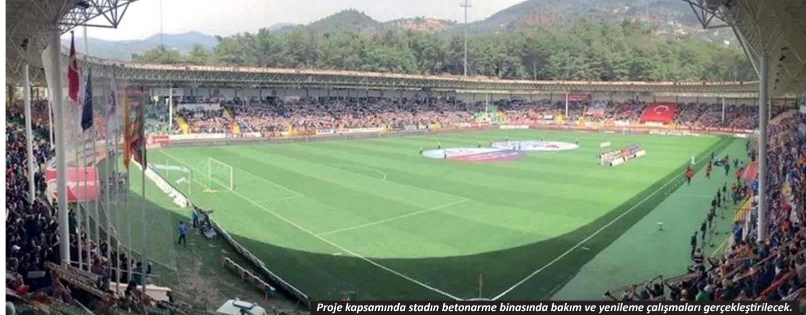
Proje kapsamında stadin betonarme binasında bakım ve yenileme çalışmaları gerçekleştirilecek.
