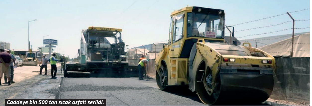
Caddeye bin 500 ton sıcak asfalt serildi.
