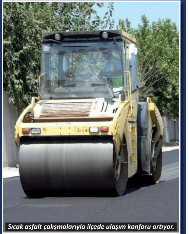
Sıcak asfalt çalışmalarıyla ilçede ulaşım konforu artıyor.
