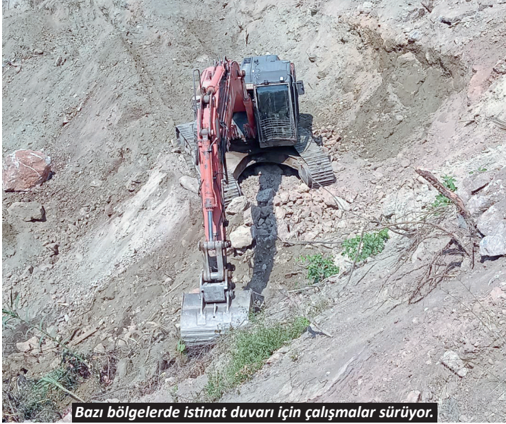
Bazı bölgelerde istinat duvarı için çalışmalar sürüyor.
