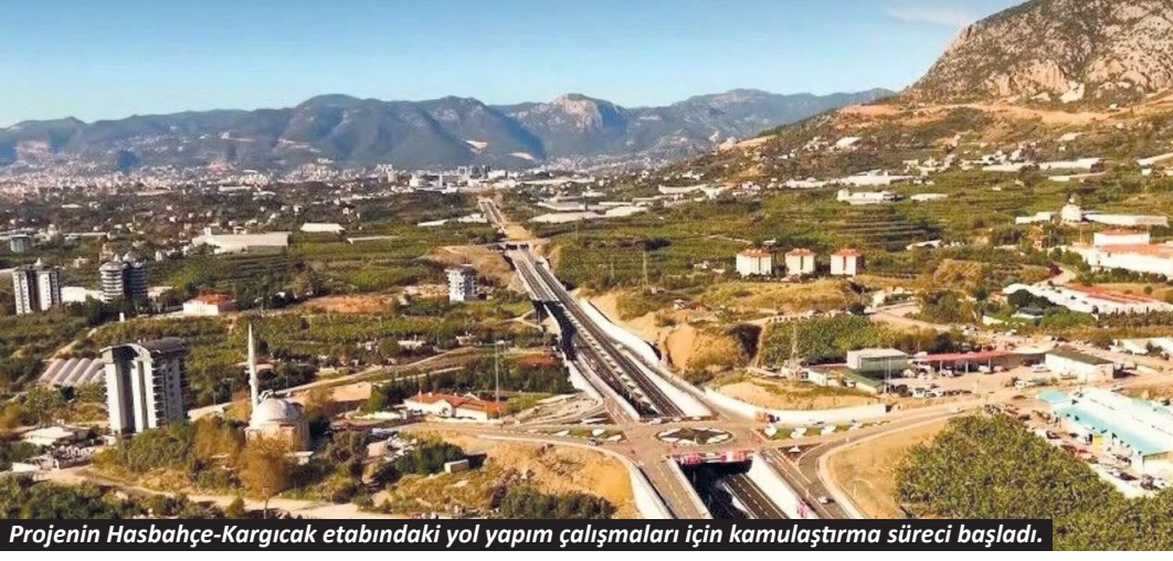
Projenin Hasbahçe-Kargıcak etabındaki yol yapım çalışmaları için kamulaştırma süreci başladı.
