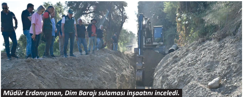
Müdür Erdanışman, Dim Barajı sulaması inşaatını inceledi.
