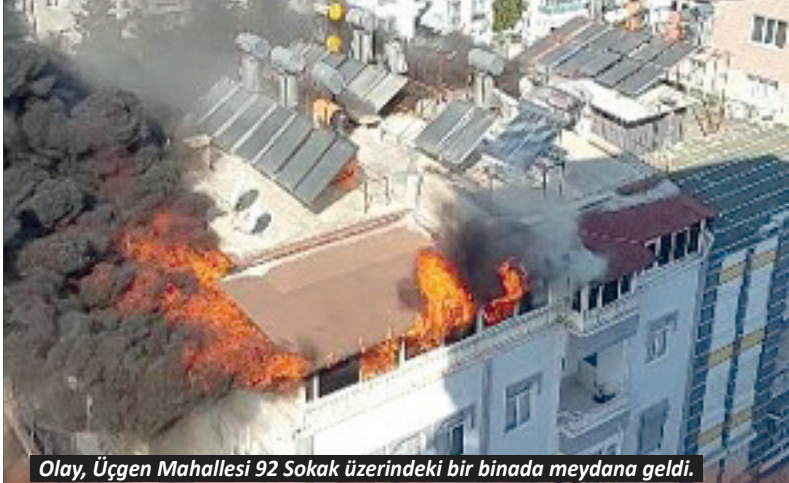
Olay, Üçgen Mahallesi 92 Sokak üzerindeki bir binada meydana geldi.
