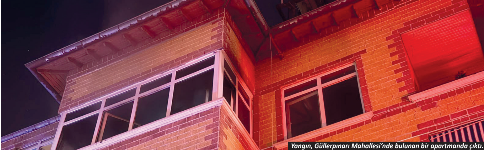
Yangın, Güllerınarı Mahallesi'nde bulunan bir apartmanda çıktı.
