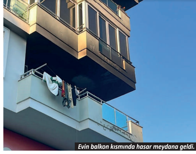
Evin balkon kısmında hasar meydana geldi.
