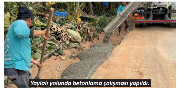
Yaylalı yolunda betonlama çalışması yapıldı.
